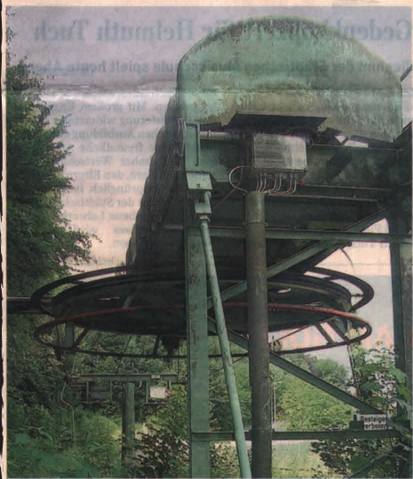
Die Talstation des 1996 stillgelegten Sessellifts könnte schon in wenigen Jahren zu neuen Ehren kommen. Fotos: SZ
